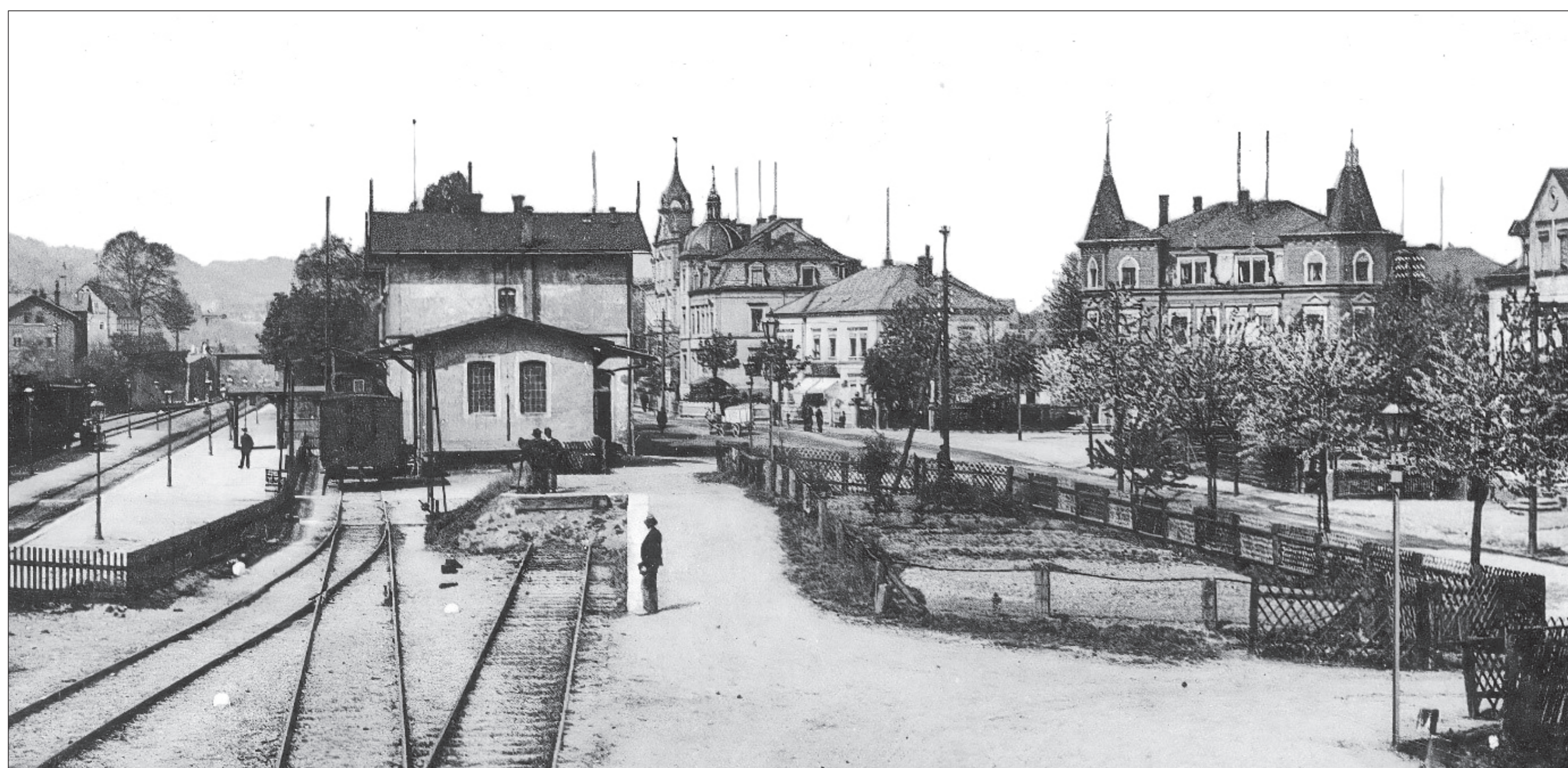
Bahnhof Cossebaude, Blick aus Richtung Dresden zur Güterabfertigung. Foto: Verlag H. Horn, alamy
